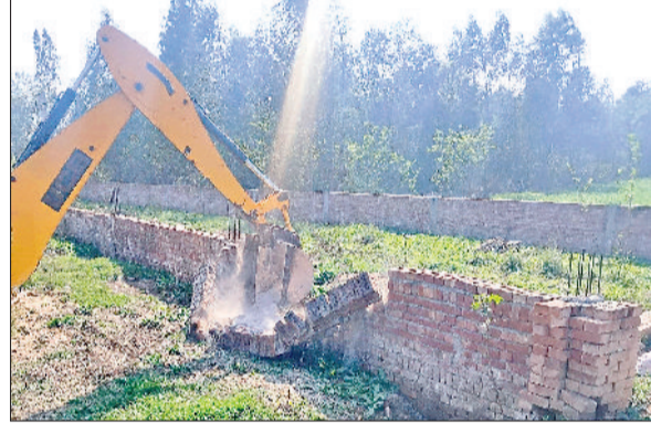
अंबाला। कॉलोनियों में हुए अवैध निर्माण को ढहाती जेसीबी।
